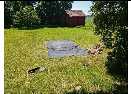
Dammduken på plats.
