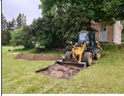
Ett par dm djup, typ. Sandbäddssanden på plats.
